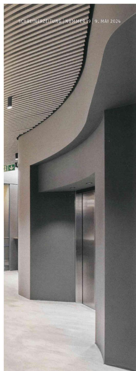
**Im Kreis zu denken, war gefragt. Beim ovalen Baldachin hat keine der Lamellen den gleichen Radius, sie wurden bogenförmig gefräst.**
