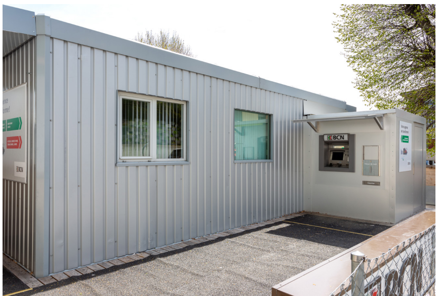
Ansicht Aussen mit Automaten-Modul rechts / Vue extérieure avec module DAB à droite
